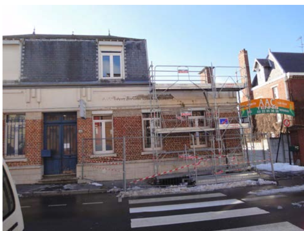
Rénovation de la toiture
